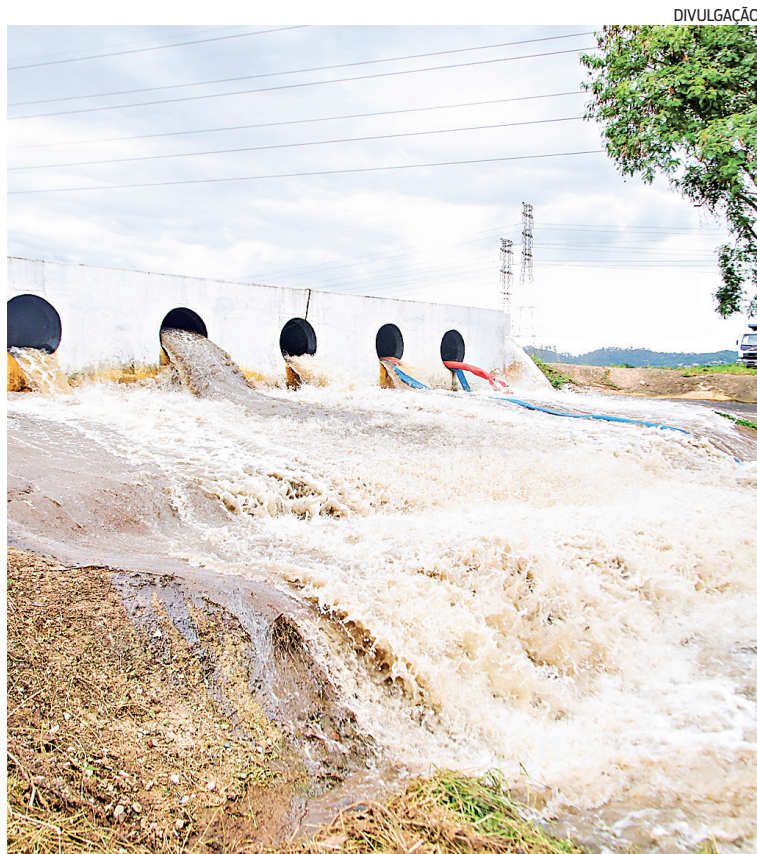
Canal do Outeiro tem capacidade de escoamento de 40.800 m³/h
