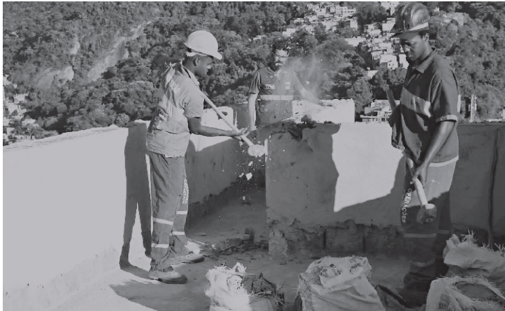
Demolição é feita de forma manual, com ferramentas portáteis
