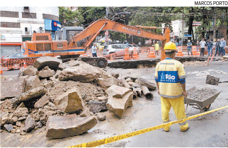
Buraco para reparos em uma galeria de águas pluviais
