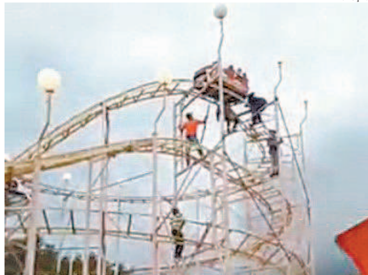
Carrinho ficou travado na parte alta, a cerca de 15 metros do chão
