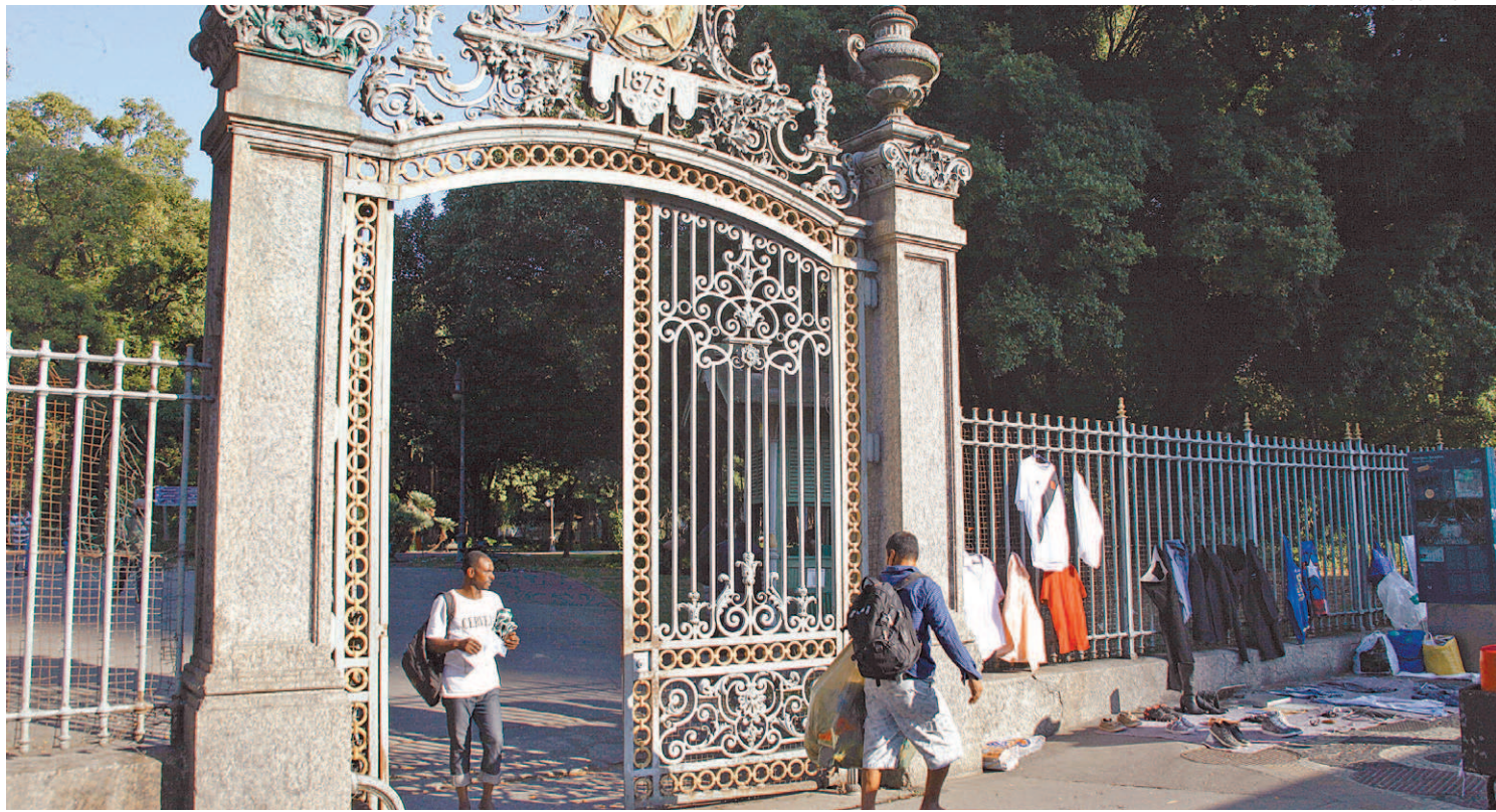
Além da depredação das ponteiras do gradil, o Campo de Santana, no coração do Centro, tem lixeiras quebradas e até fiação exposta
