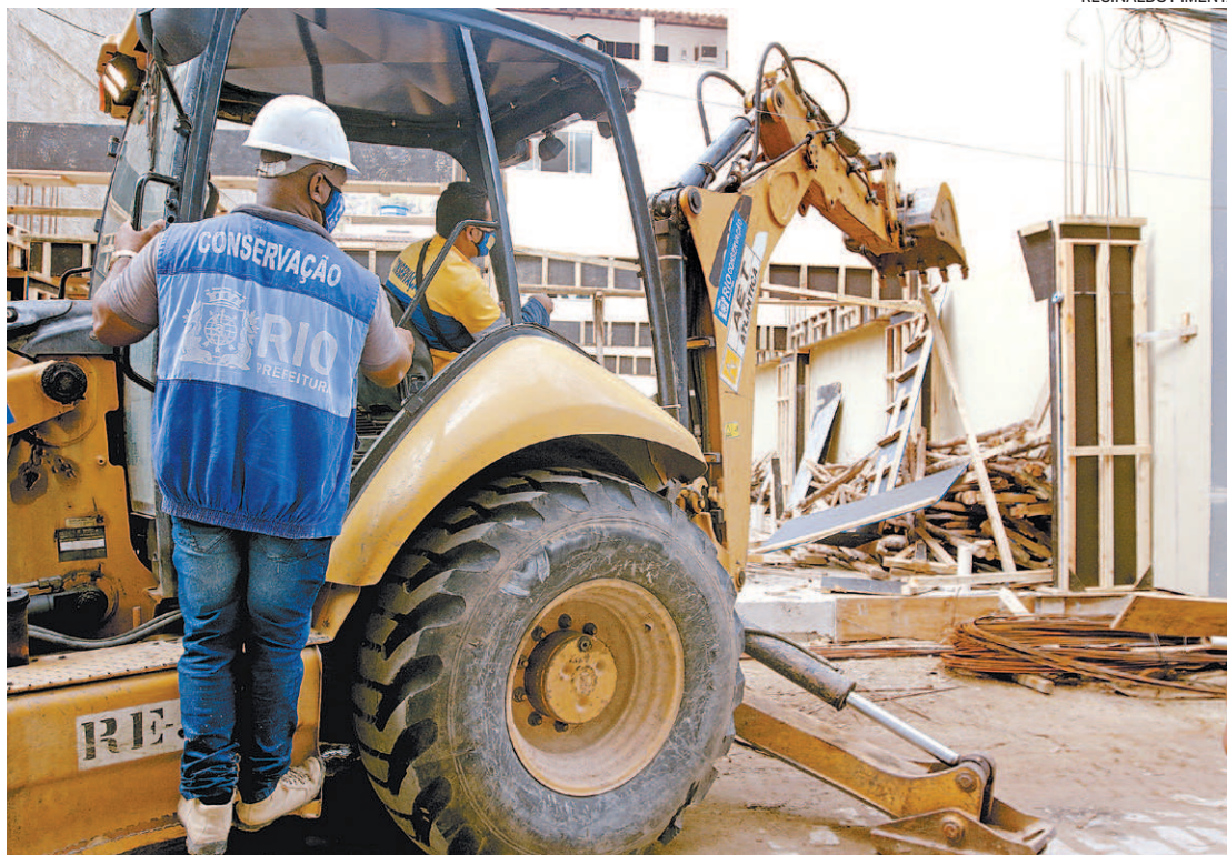
Construção irregular começa a ser demolida na Muzema. Eduardo Paes fez um alerta: “Não comprem!”
