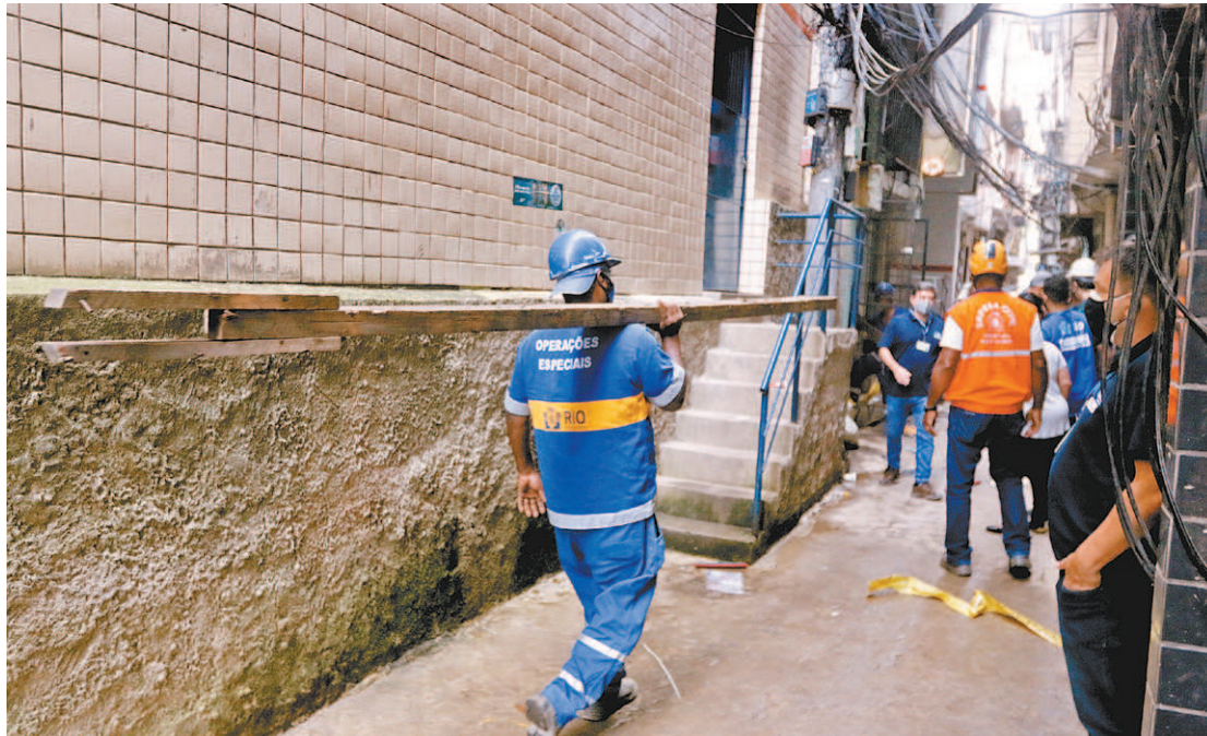
Prédio em Rio das Pedras, na Zona Oeste, foi interditado para demolição de dois pavimentos
