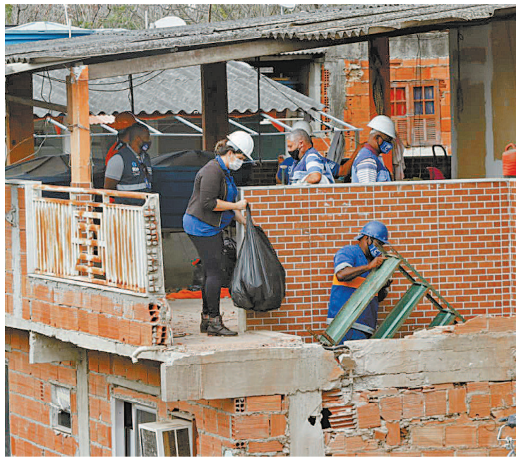
Terraço de prédio grudado ao que caiu começou a ser demolido
