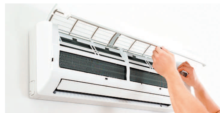
Ar-condicionado: limpar o filtro periodicamente é importante
