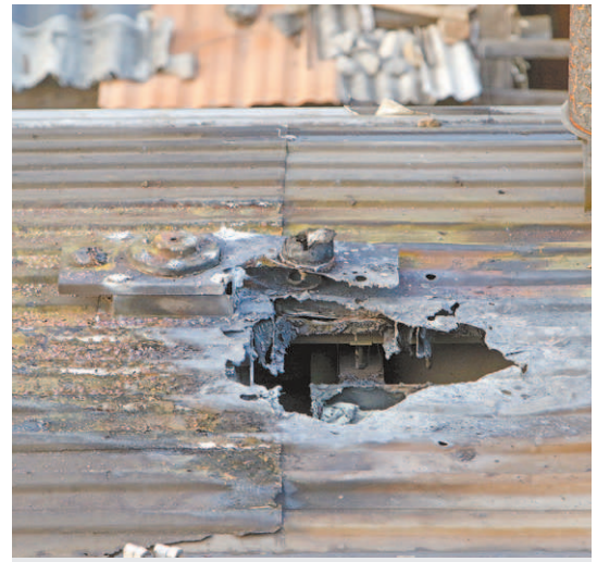
Teto de composição ficou com rombo após incêndio
