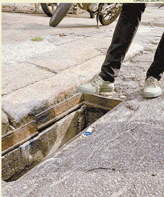
Bocas de lobo são roubadas em São Cristóvão
