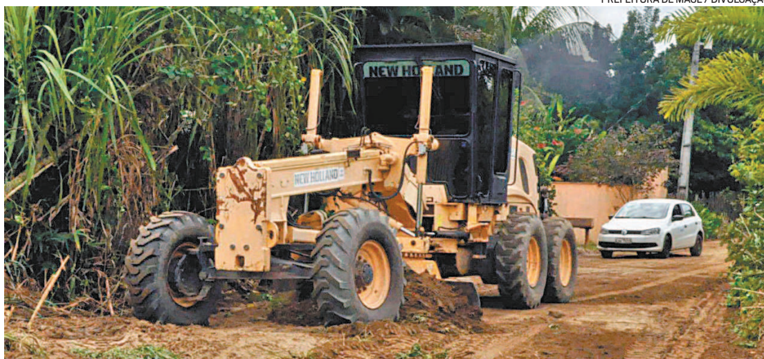
Melhoria na zona rural de Magé: cerca de 20 vias recebem obras, que começaram na última segunda-feira
