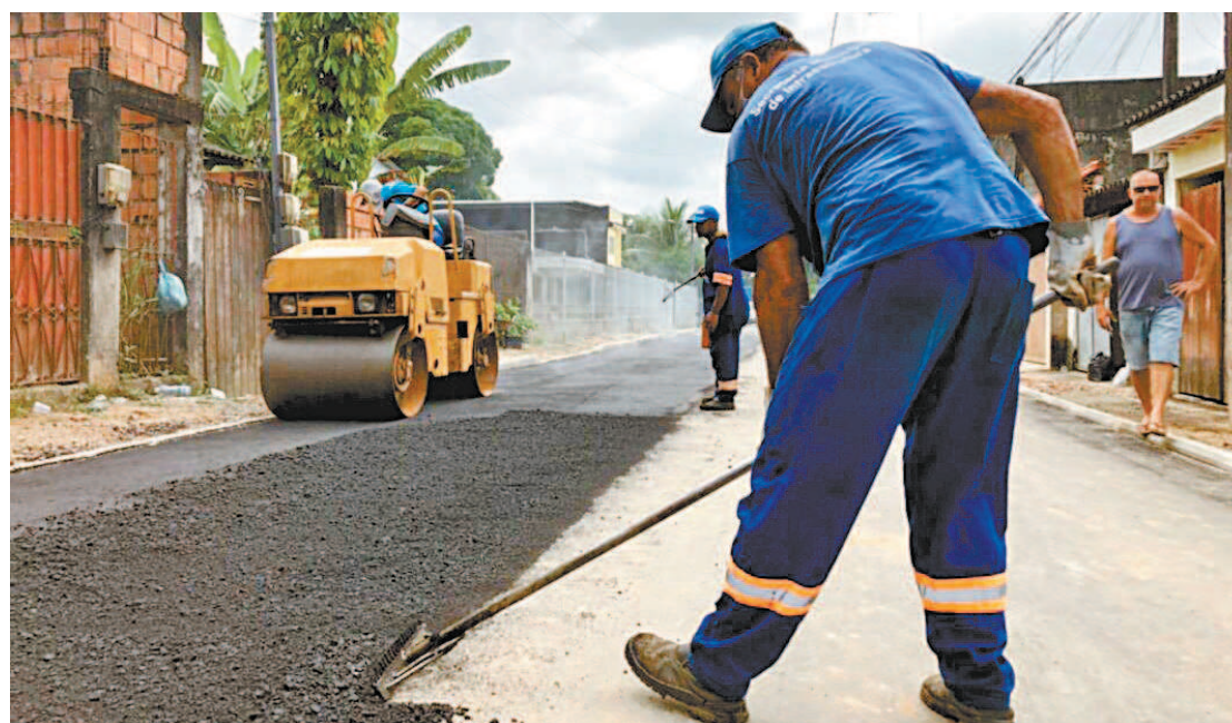
Diversas ruas da cidade receberam serviço de recapeamento asfáltico para melhorar a circulação
