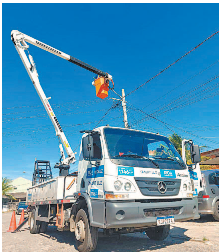
Pontos sem luz em Santa Cruz receberam equipes de manutenção
