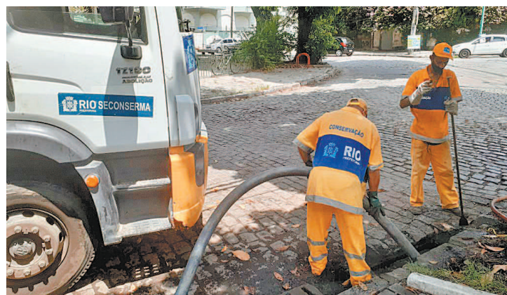
Limpeza de bueiros e reposição de tampas foram algumas das ações
