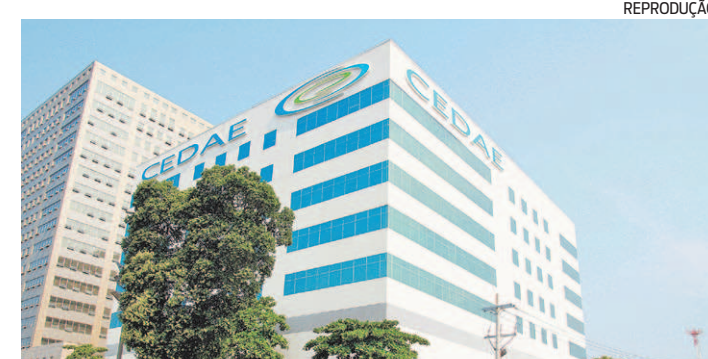
Cedae fará obras de manutenção preventiva na estação Manilha
