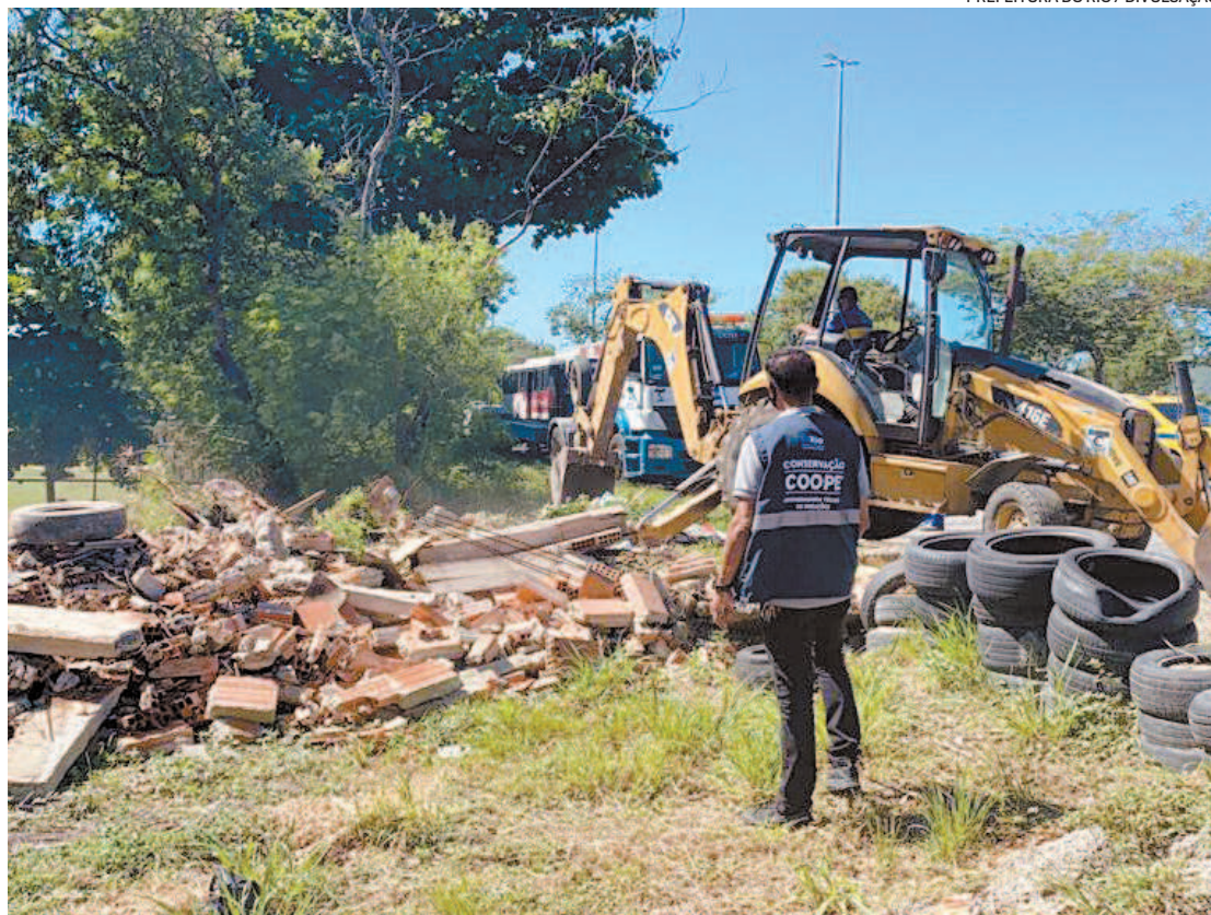
Em Realengo, as equipes demoliram uma edificação que havia sido erguida em uma área destinada à praça
