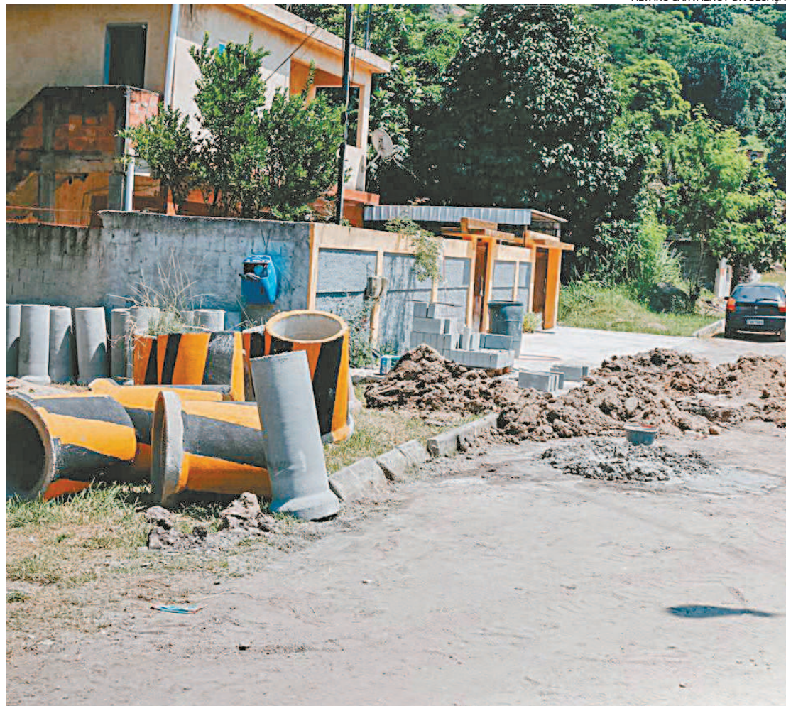
A Secretaria de Infraestrutura de Magé está pavimentando e colocando manilhas na Rua Vitória Régia
