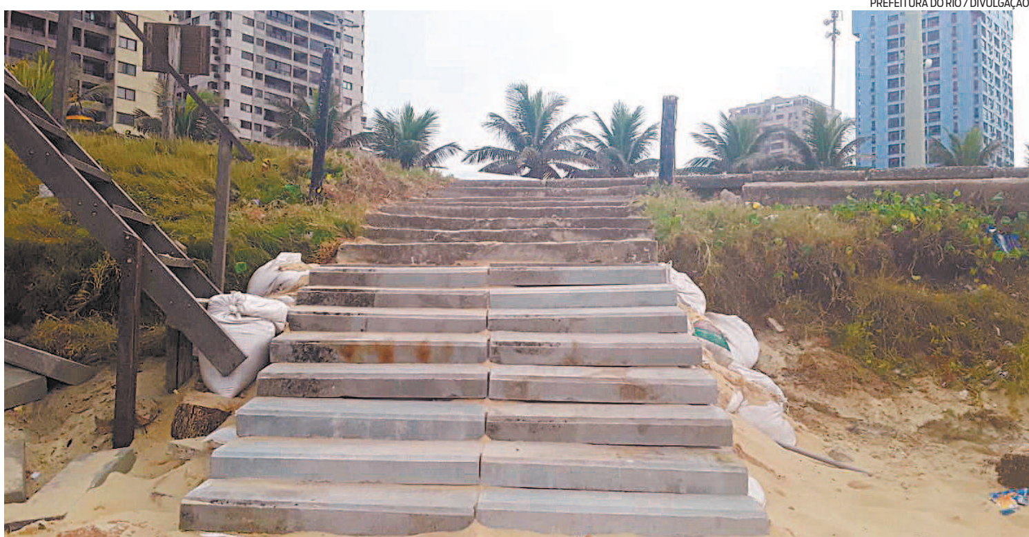
As escadas, que permitem o acesso dos banhistas à praia da Barra, tiveram que ser reconstruídas por conta das ressacas do ano passado
