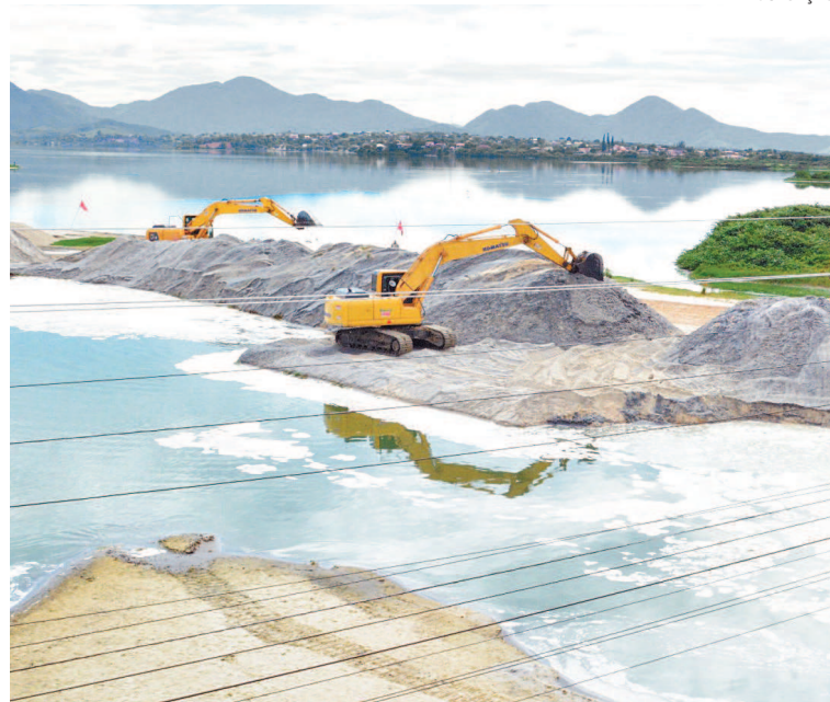
Máquinas trabalham na reabertura do canal da Barra de Maricá
