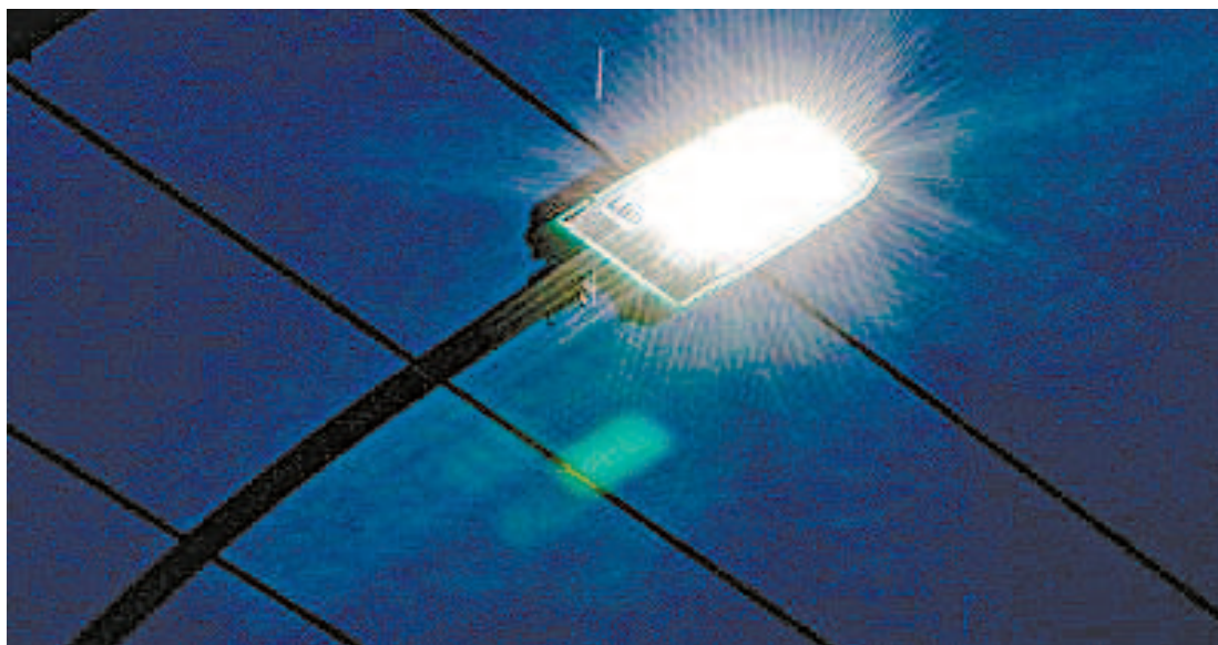
Cronograma prevê a instalação de 45 mil novos pontos de iluminação de Led na cidade até 31 de março
