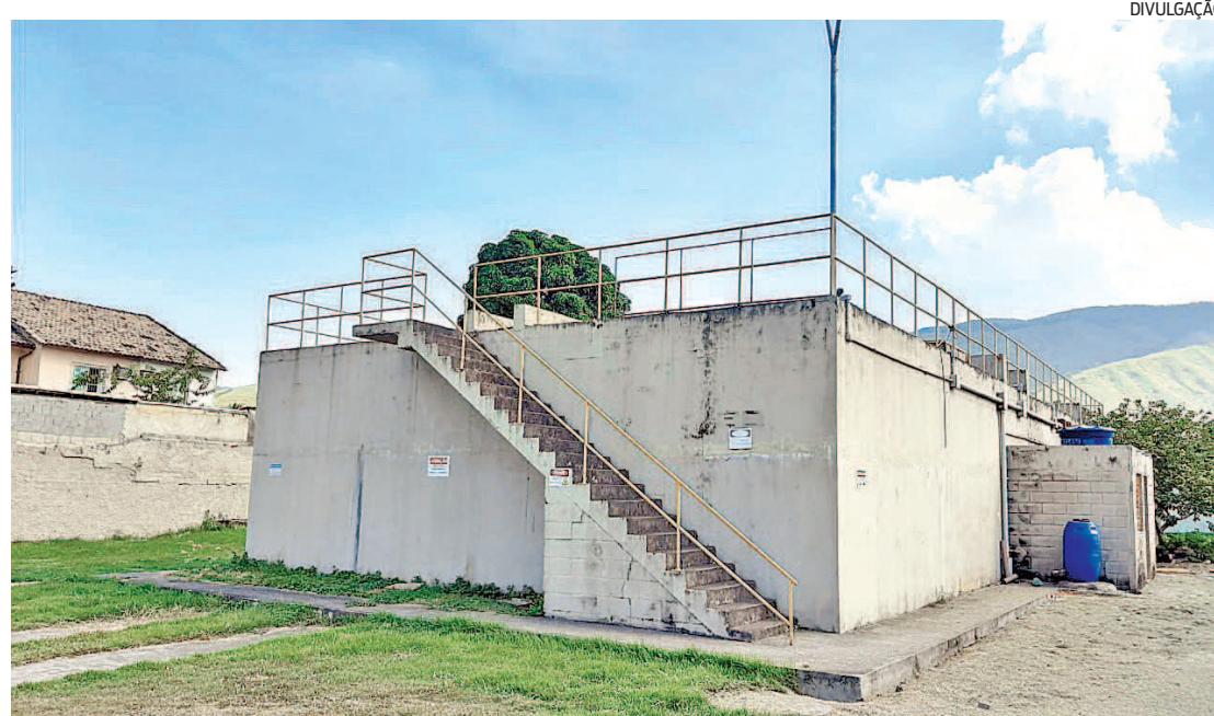
O esgoto captado pela nova rede desemboca na ETE da Rua Bernardino de Melo
