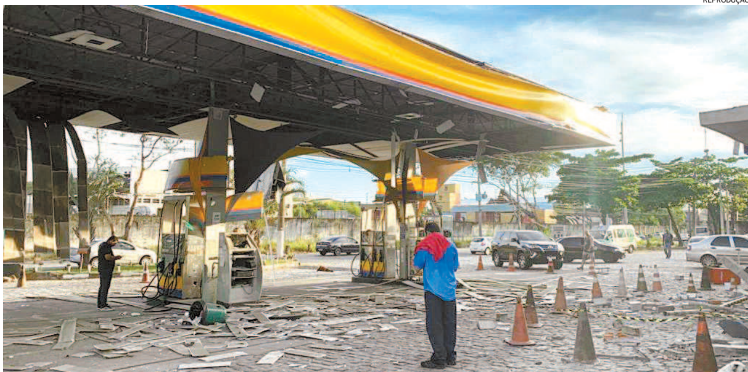
Depois da explosão: uma parte da loja de conveniência do posto ficou quebrada, com direito a detritos espalhados pelo chão do local
