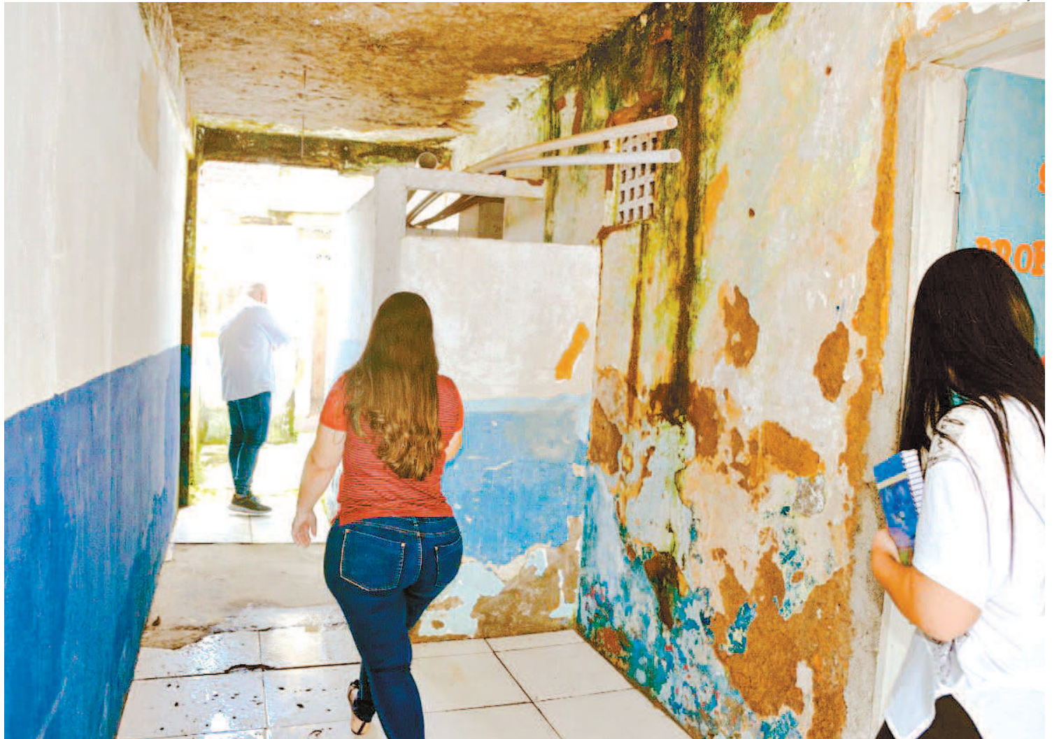
A vistoria encontrou paredes com mofo e muita sujeira, mas a gestão anterior diz que “o espaço está desativado há dois anos”
