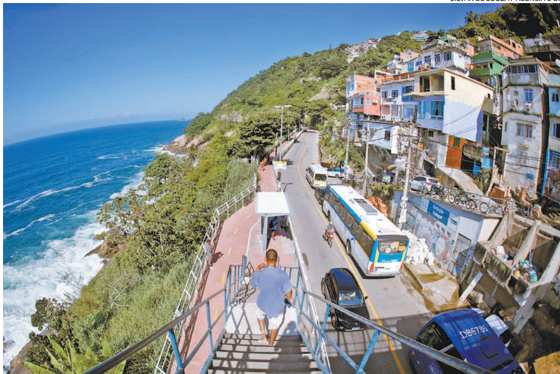
Avenida Niemeyer: local ganha ação preventiva para manutenção, sempre que houver necessidade
