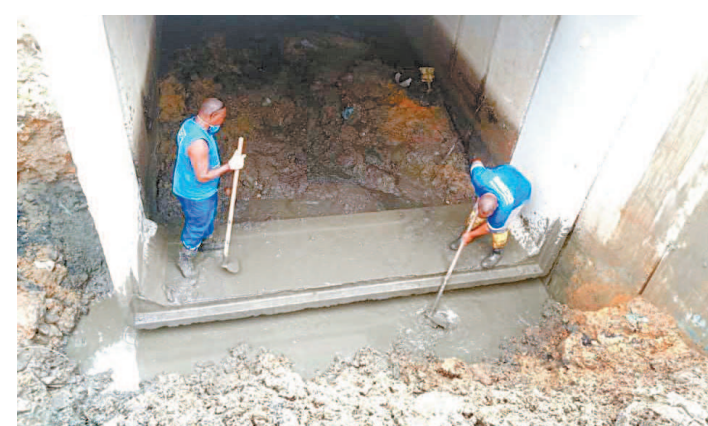
Funcionários trabalham na Canalização do Canal Farias, em Caxias
