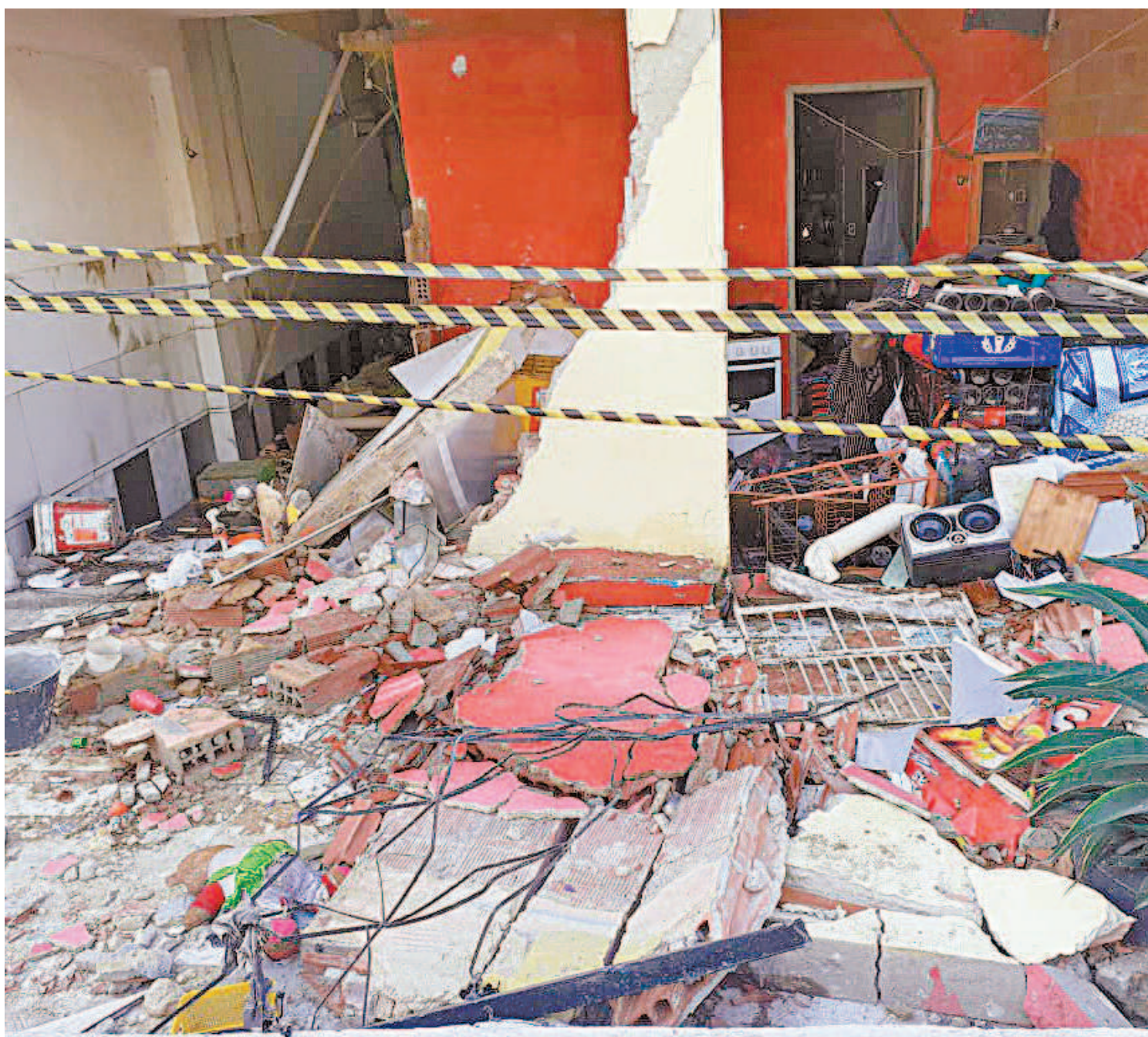
A casa da família ficou completamente destruída após a explosão que matou mãe e dois filhos em São João de Meriti, na Baixada
