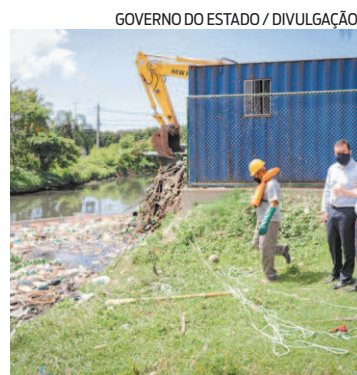
Primeira foi instalada no Rio Anil
