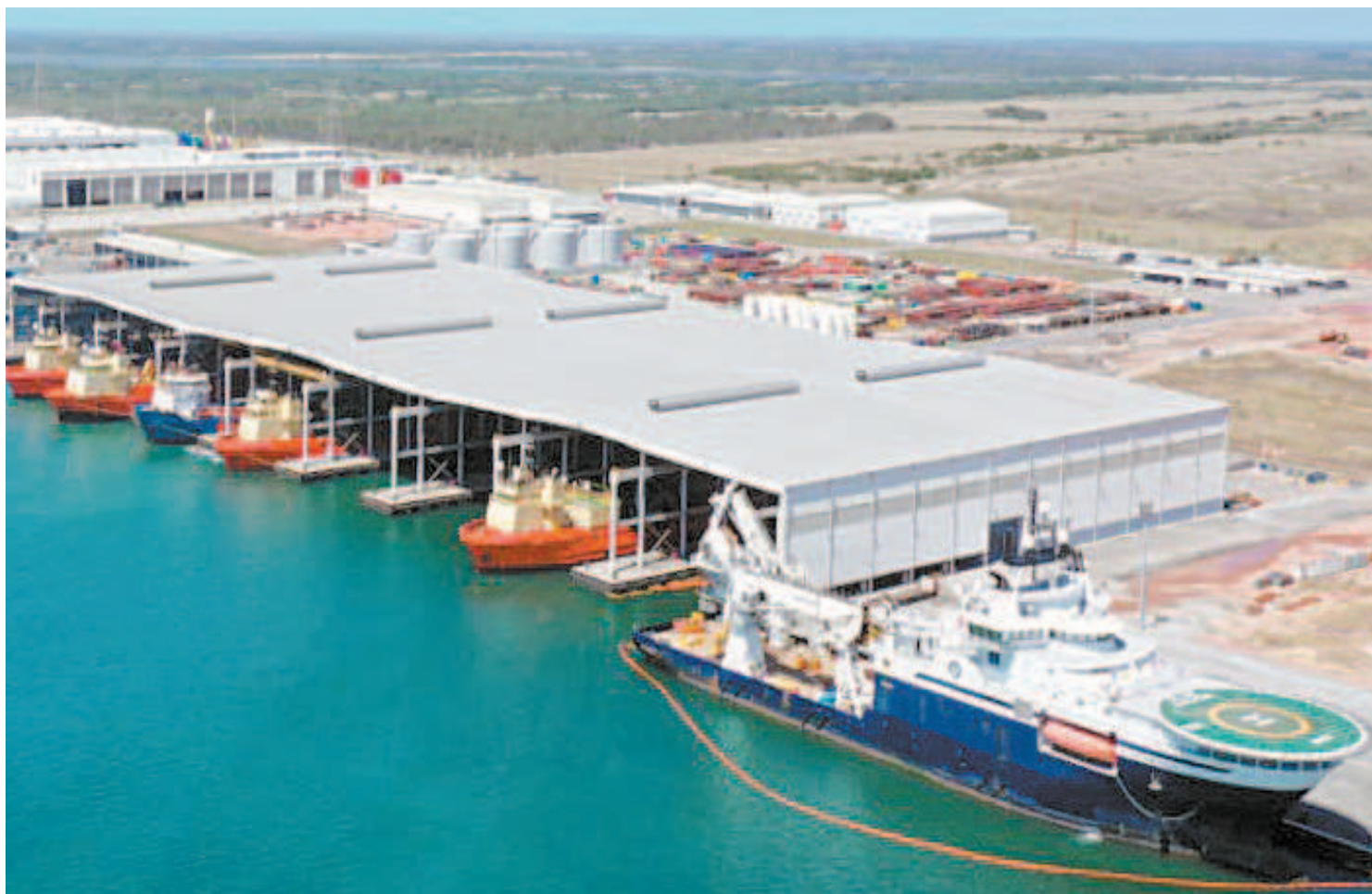
Empresa que vencer a licitação, e pode até ser estrangeira, vai implementar e administrar a ZPE no Porto do Açu, no Distrito de São João da Barra
